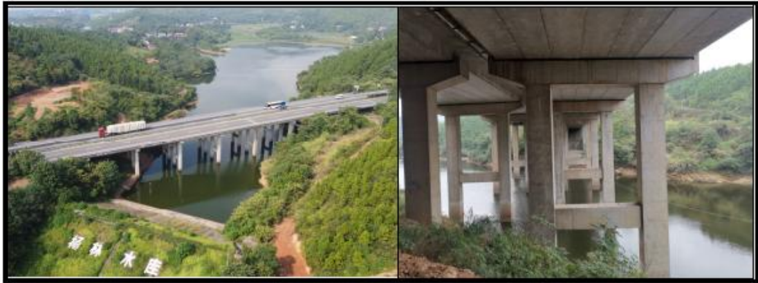
图 2.1-6 杨林水库大桥
