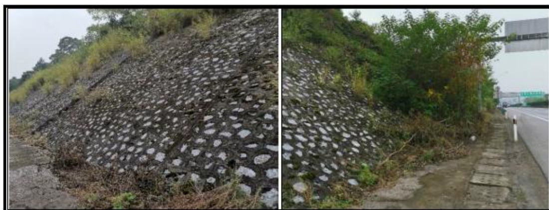
图 2.1-4 现状路基边坡防护
