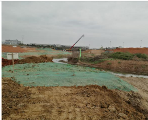
项目北面环境现状
