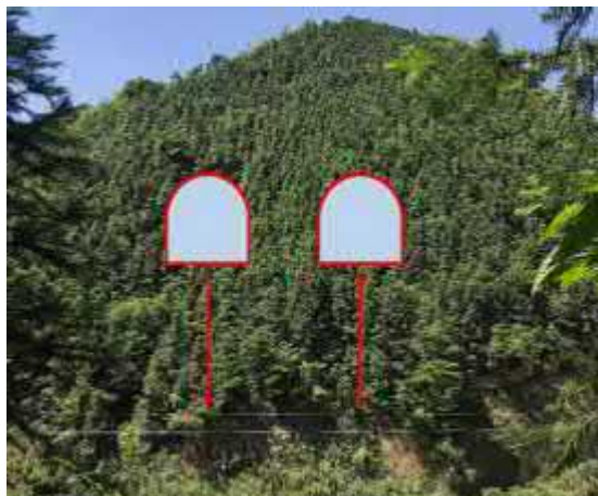
紫金山 3 号隧道零陵端洞口
