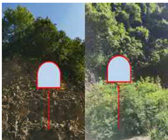
紫金山 2 号隧道零陵端洞口
